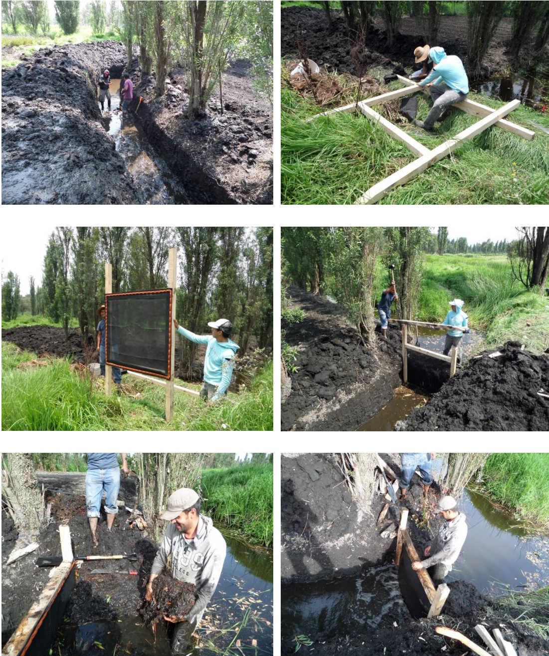
Figura 34. Rehabilitación de la zanja “Tilac” y colocación de la compuerta.
