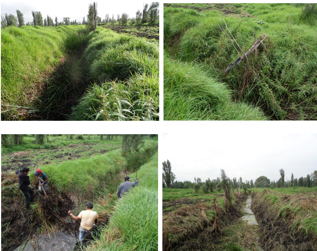
Figura 30. Rehabilitación de la zanja “Paso del Águila”.
